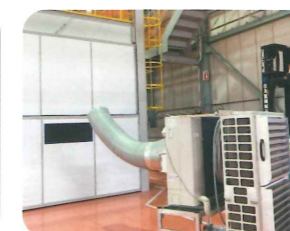
高所作業場（住友重機械モダン様）
