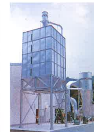
サイクロン集塵装置・ファン45KW・集塵室50m 3
